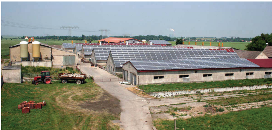
Foto: meridian Neue Energien GmbH
